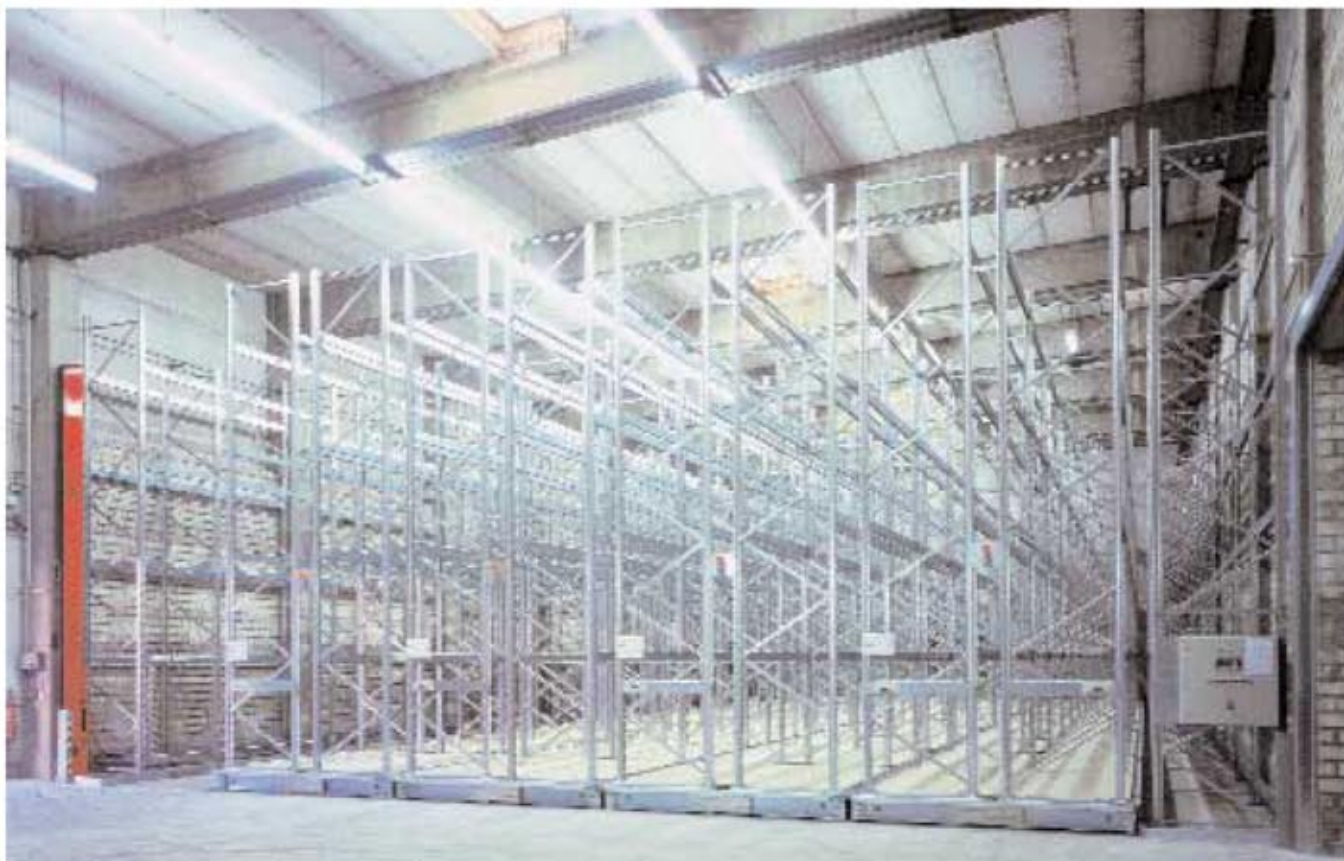
MOV O installasjon før innflytting.
